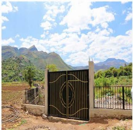
يمتد السياج لحوالي 420 مترًّا وارتفاع 1.5 متر، بما يعزز دور الكرفان في الاستفادة القصوى من مياه الأمطار، وحجز ما يقارب 100 ألف متر مكعب من المياه سنويًّا لتغذية الخزان الجوفي للمحافظة
